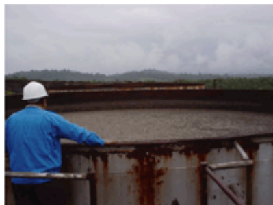
同工場内の廃液嫌気処理タンク上部から放出されるメタンガスを調査
